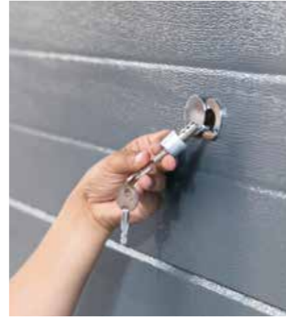
Desbloqueador externo de chave (motor de teto)
